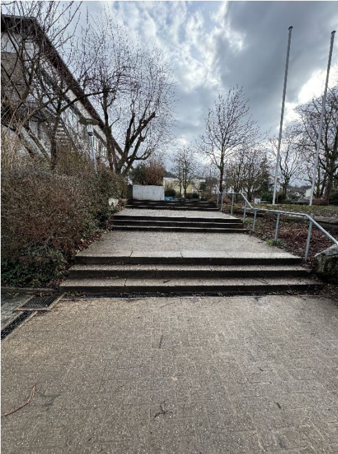
Zuge von Schulhof zu Haupteingang Pavillon
