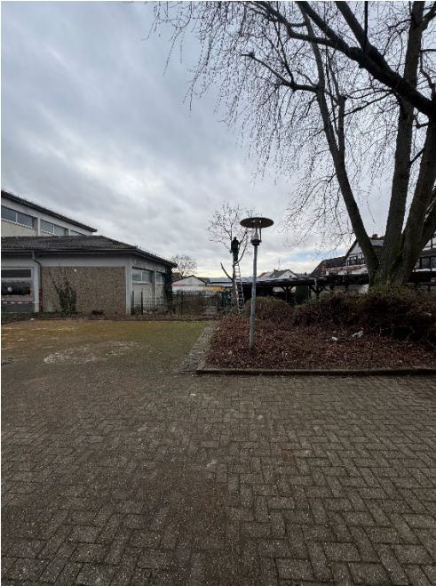
Ansicht Anbau Innenhof, mit Zuweg
