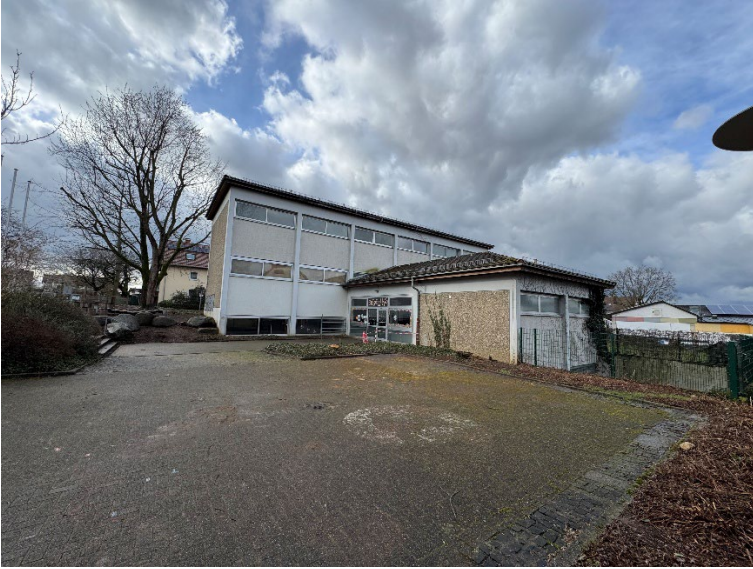
Ansicht Innenhof, Hauptgebäude mit Anbau
