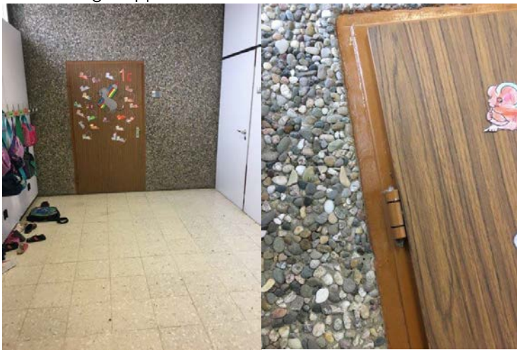
Waschbetonelemente und Türen zu Grußbenräumen
