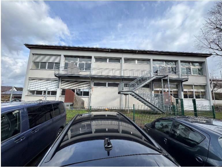
Ansicht Straßenseite mit Fluchtbalkon
