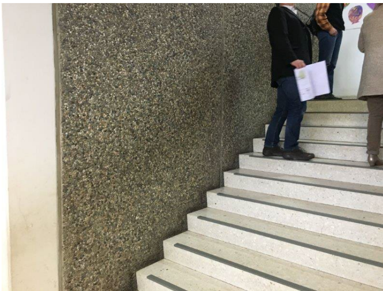
Treppenanlage mit Waschbetonelementen
